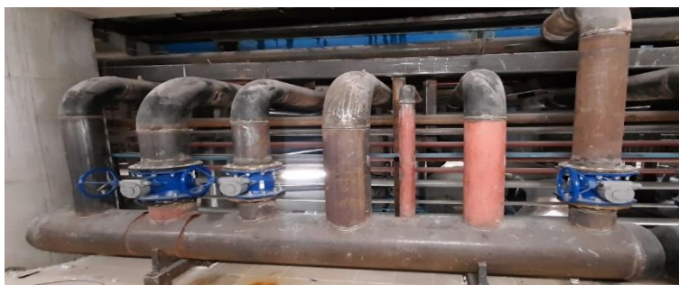
شکل (۱۴). محل اتصال منبع انبساط سرد به کلکتور مکش
