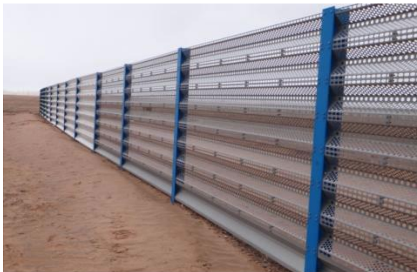
شکل (۱۲). فنس های حفاظتی برای جلوگیری از ورود ماسه
