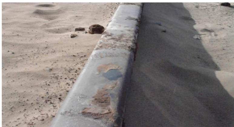
شکل (۱). خوردگی ریل و دوات روسازی، شکستگی تراورس، نفوذ ماسه داخل بالاست
