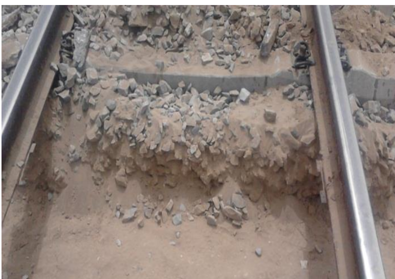
شکل ۲: خوردگی ریل و دوات روسازی، شکستگی تراورس، نفوذ ماسه داخل بالاست
