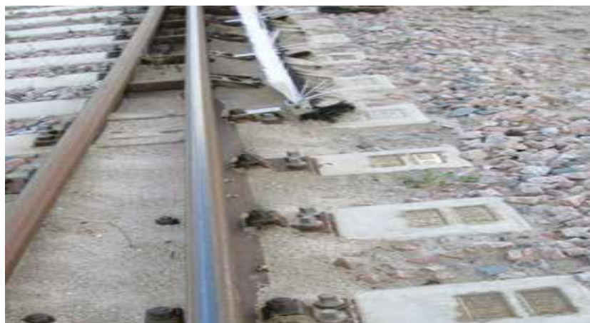
شکل ۸: چیدمان و کارایی برس جهت دهنده مسیر باد
