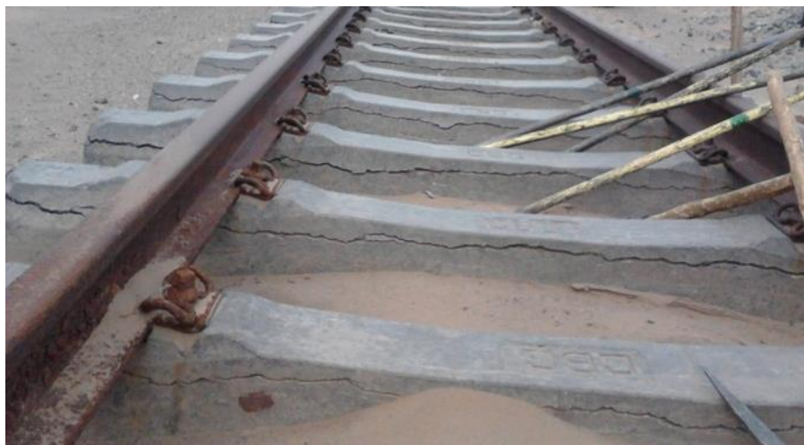
شکل (۴). خوردگی ریل و دوات روسازی، شکستگی تراورس، نفوذ ماسه داخل بالاست
