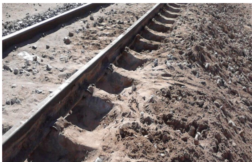
شکل (۹). تخلیه بالاست بین تراورس ها
