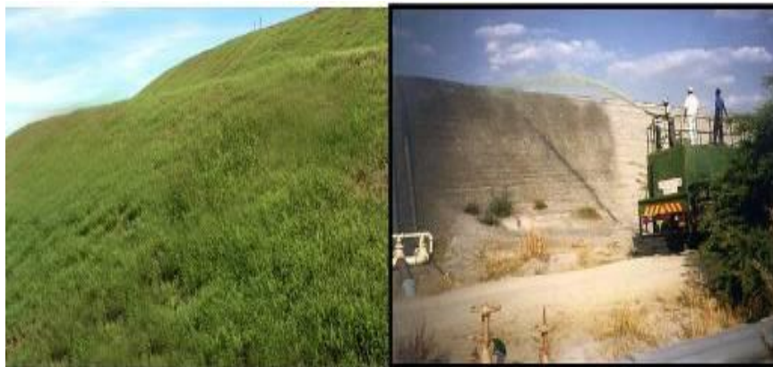
شکل (۱۷). مرحله پاشیدن بذر بر روی زمین بایر و ایجاد تپه سبز به روش هایدروسیدینگ
