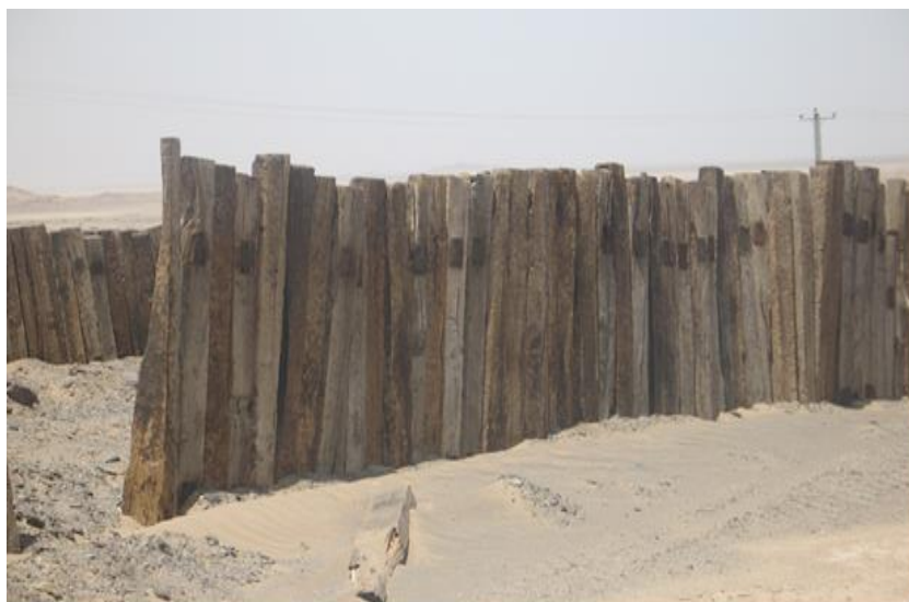
شکل (۸). احداث دیوار حائل
