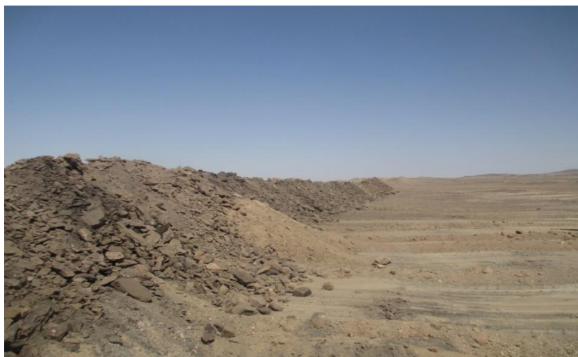
شکل (۶). خاکریزهای احداث شده
