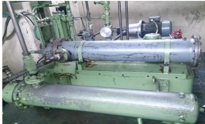
شکل (۱). نمایی از سیستم خنک کاری دستگاه پرس هیدرولیکی ۶۳۰ تن
